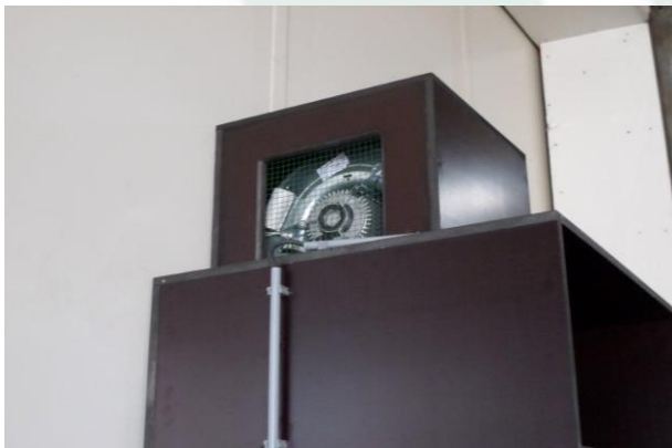
Ventilador centrífugo para la extracción de aire acondicionado que se sopla por la semilla.
